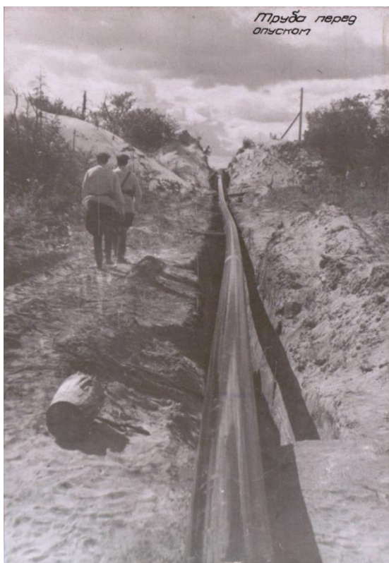
Труба перед опуском (Из фотоальбома «Строительство нефтепровода Оха на Сахалине – Софийск на Амуре 1942 г.». ГАХК. Ф. Ф. 4. Оп. 2. Д. 11. Л. 28)
