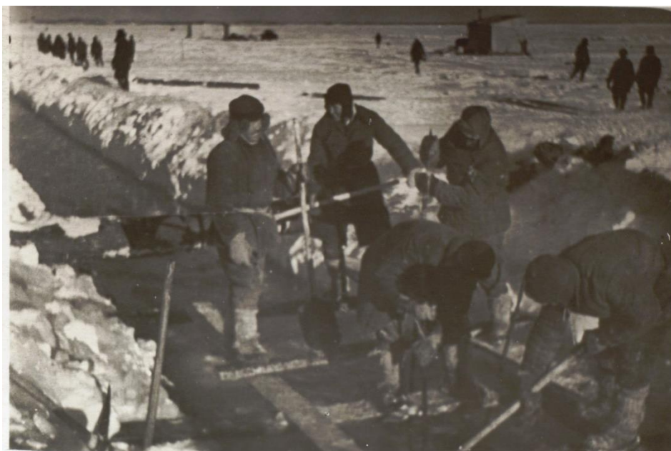
Подготовка к опуску труб в проливе (Из фотоальбома «Строительство нефтепровода Оха на Сахалине – Софийск на Амуре 1942 г.». ГАХК. Ф. Ф. 4. Оп. 2. Д. 11. Л. 19)
