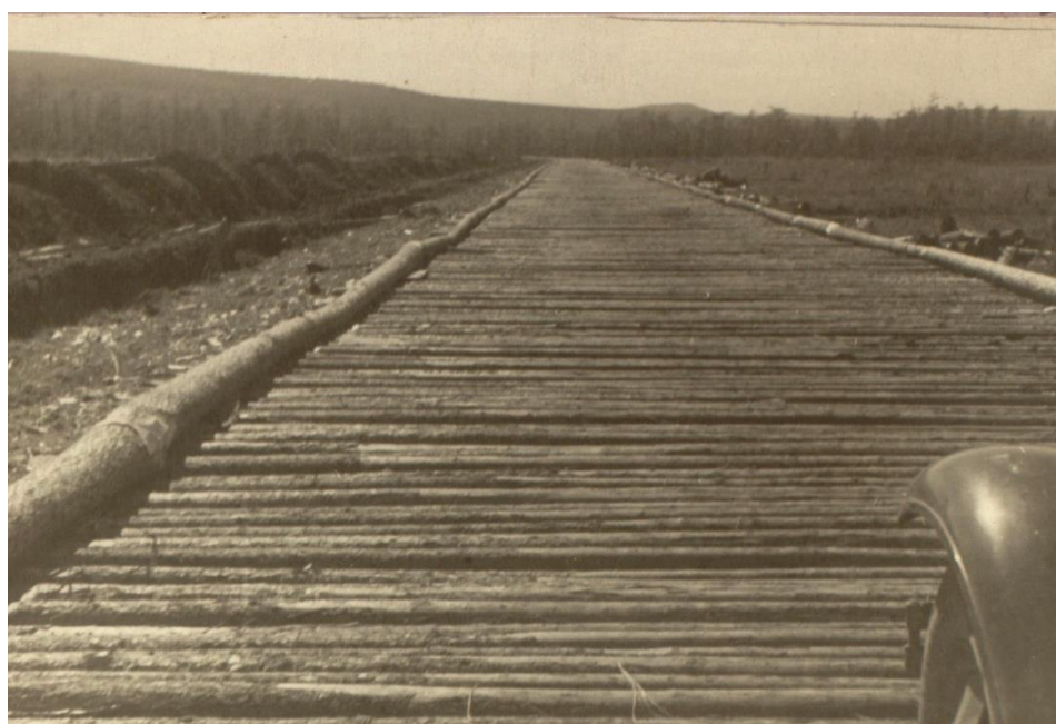
Лежневая дорога на Сахалине (Из фотоальбома «Строительство нефтепровода Оха на Сахалине – Софийск на Амуре 1942 г.». ГАХК. Ф. Ф. 4. Оп. 2. Д. 11. Л. 5)
