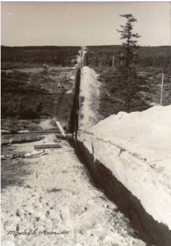
Труба в траншее (Из фотоальбома «Строительство нефтепровода Оха на Сахалине – Софийск на Амуре 1942 г.». ГАХК. Ф. Ф. 4. Оп. 2. Д. 11. Л. 27)
